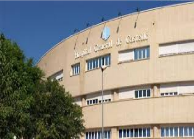
Hospital Univ. General de Castellón.
